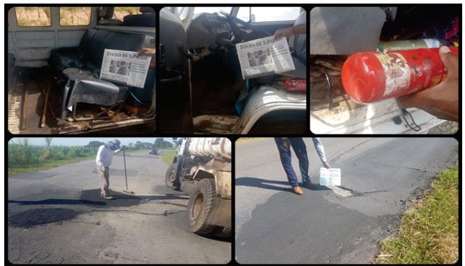
Asfalto: Atentem-se para as condições do caminhão e da Kombi destinada ao transporte dos servidores, extintores de incêndio vencidos, placas de perigo enferrujadas, falta de sinalização (cones) na estrada para proteção dos servidores.
